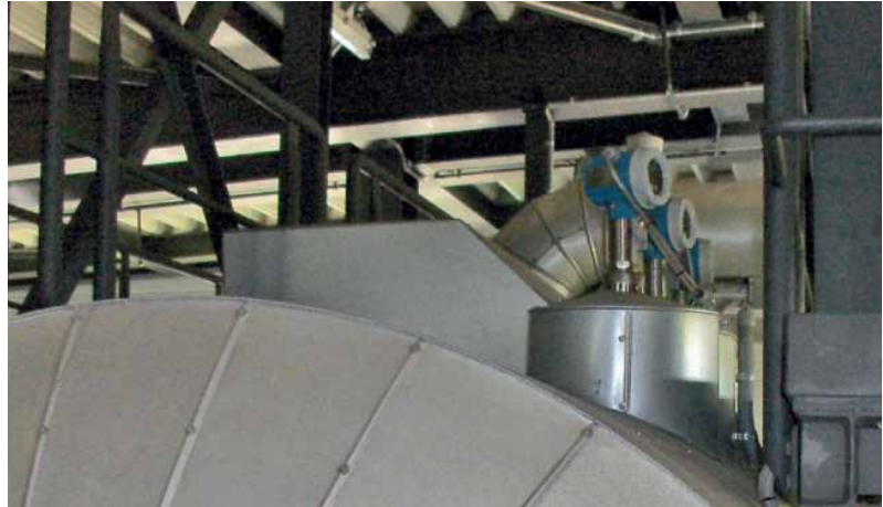
Měření hladiny v bubnu pomocí Levelflex FMP54 (výběr 2 ze 3)
