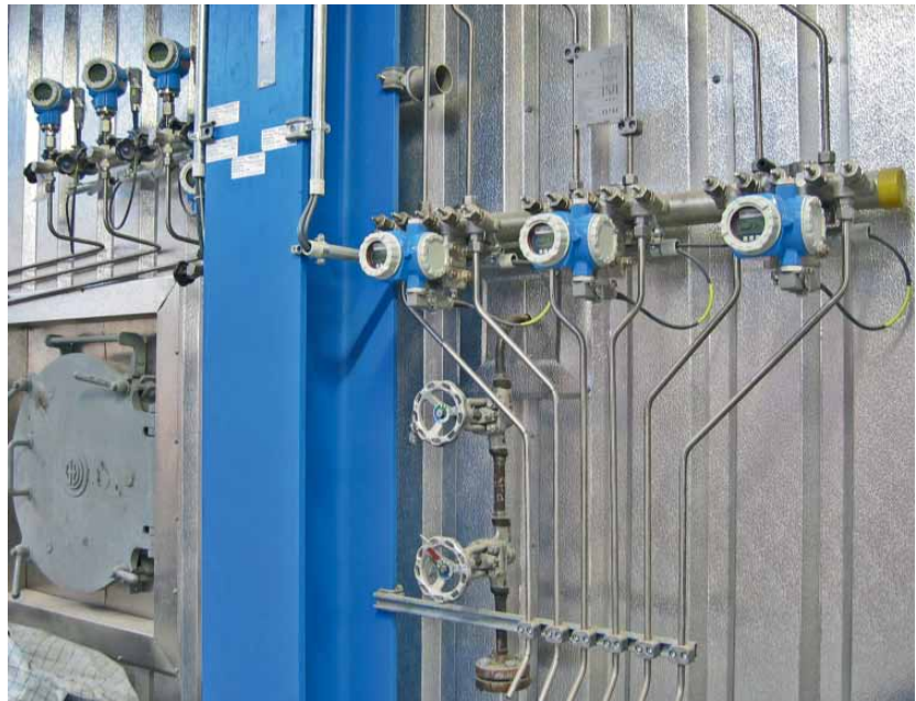
Měření hladiny v bubnu pomocí Deltabar S PMD75 (výběr 2 ze 3)
