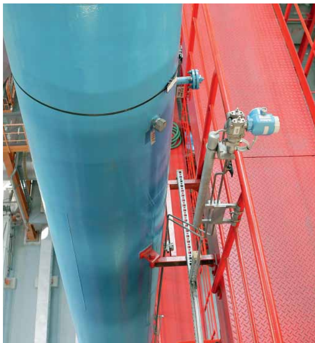
Měření průtoku sekundárního vzduchu pomocí Venturiho trubice
